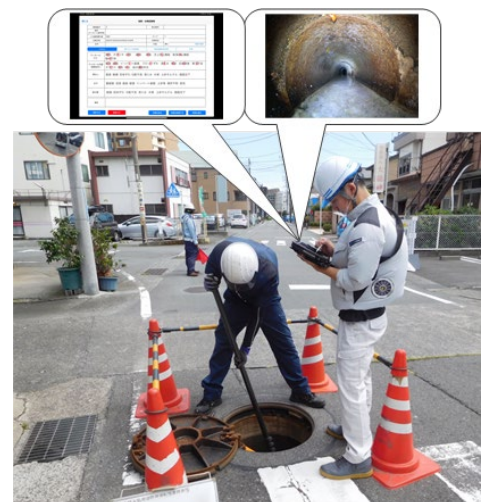
図4. 地上からの簡易的な方法による点検風景（管口カメラ調査）
